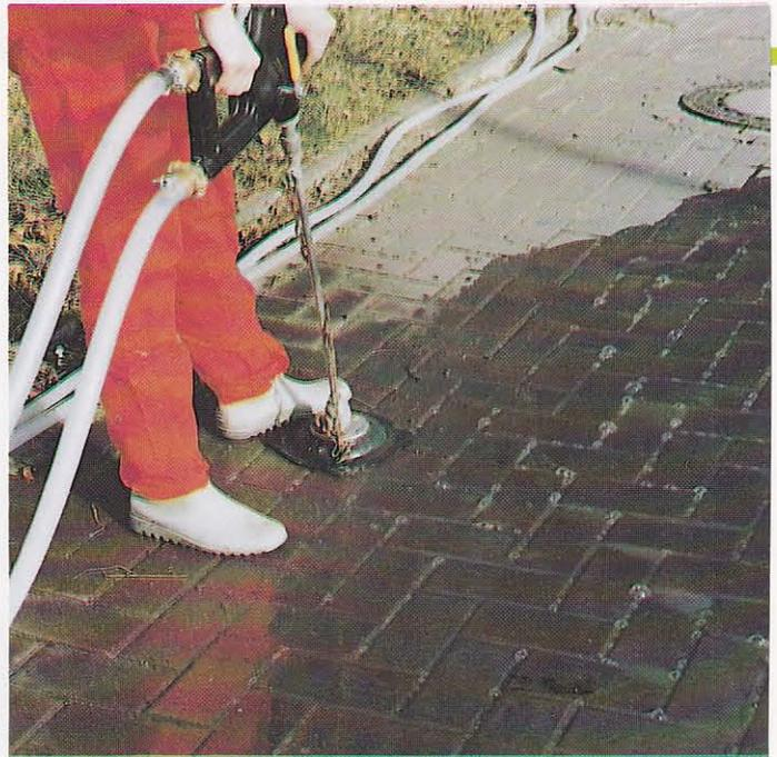
Eine Bohrung reicht aus, um mit der Injektionslanze auch unter vorhandenen Wege- und Platzflächen eine Bodenverbesserung durchzuführen.
